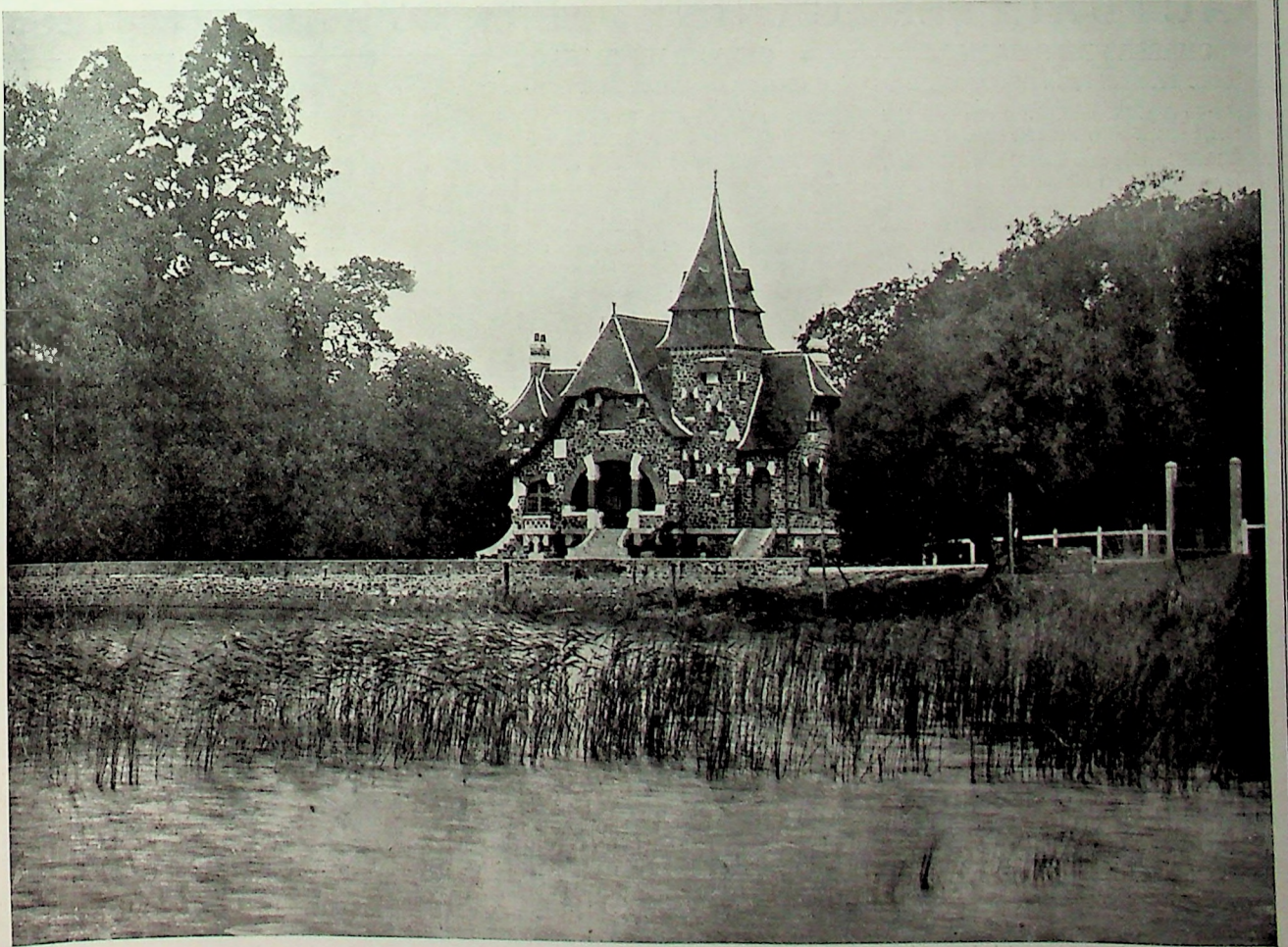
LE PAVILLON DE PÊCHE. — C'est une construction toute moderne, véritable lieu de repos, d'où l'on peut assister aux péripéties de la pêche comme de la chasse aux oiseaux d'eau. Tantôt qu'une vaste salle occupe la plus grande partie du rez-de-chaussée, le sous-sol est aménagé en buanderie et les greniers servent de séchoirs. Ses façades, qu'éclairent quelques pierres blanches aux points essentiels, sont surmontées de toitures mouvementées. (Cl. Vie à la Campagne.)
